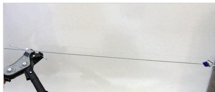
7 Mettere in tensione con il tenditore Gripple standard
